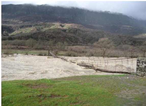
Pasarela e Mesarese
